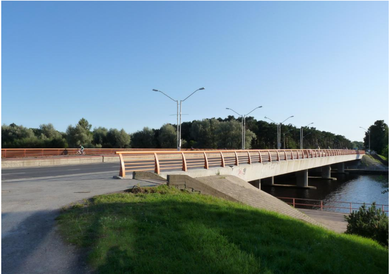
Joonis 3. Foto olemasolevast Pirita sillast enne rekonstrueerimist.
